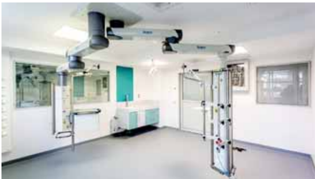
Restructuration service de pneumologie - GH PITIE SALPETRIERE - 9 850 m 2 / 12 450 000 € HT
