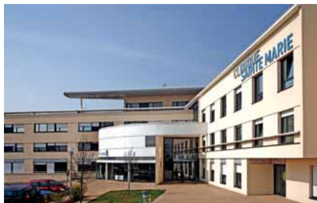
CLINIQUE SAINTE-MARIE : Construction d'un Etablissement de 138 lits à Osny (95)
