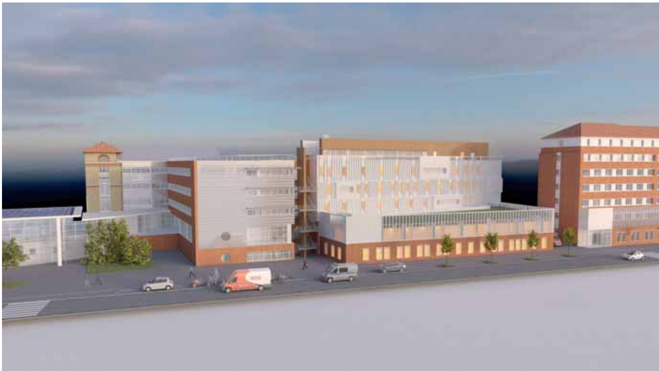
GROUPE HOSPITALIER PARIS SAINT-JOSEPH : Surélévation et extension du bâtiment Saint-Vincent à Paris (75)
