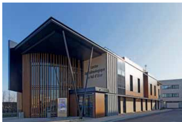
SAS COVO IMMOBILIER : Construction d'une maison médicale à Osny (95)
