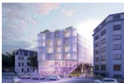
Hôpital de l'Institut Curie (75)
