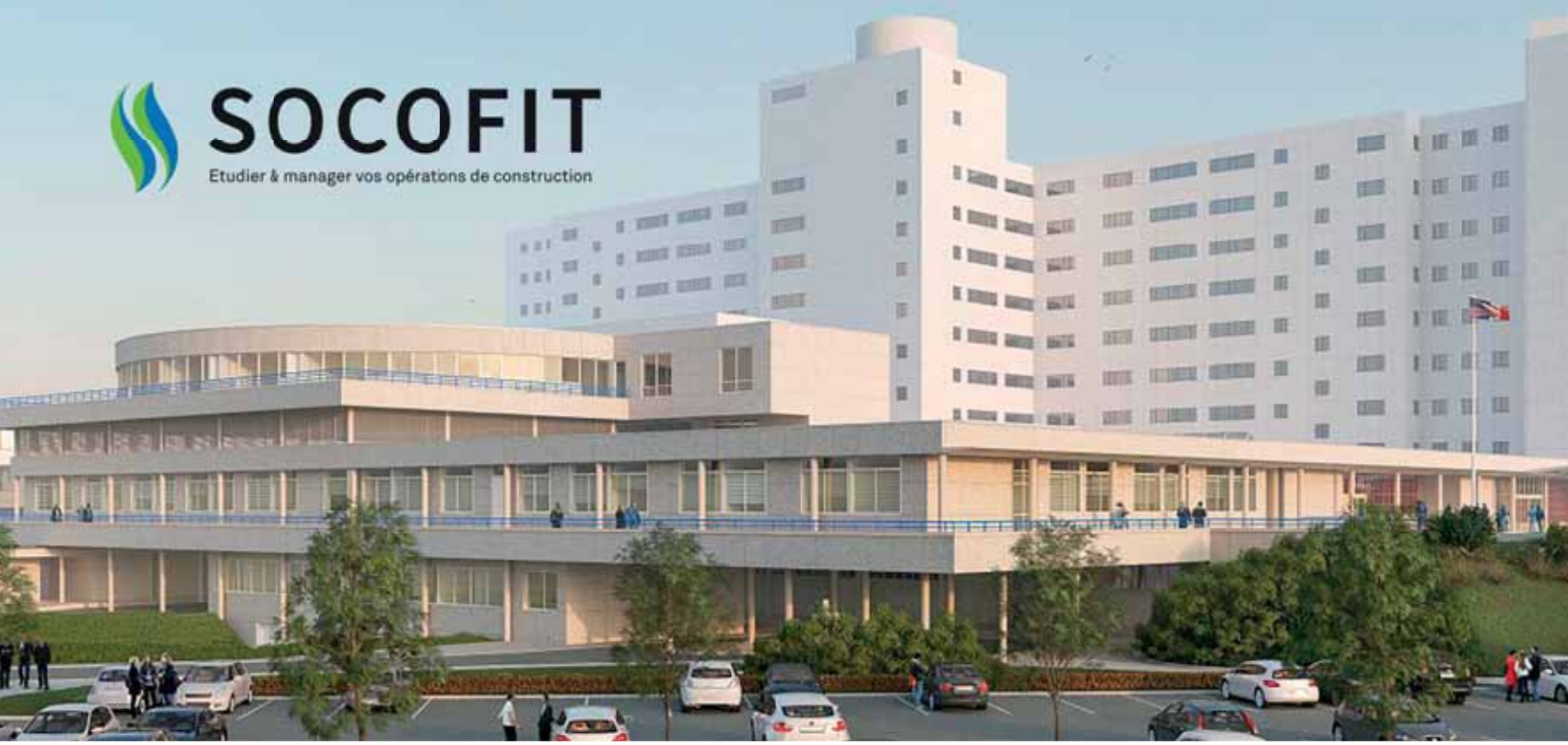
Mémorial France Etats-Unis de St Lô - Extension intégrée du nouveau service d'accueil des urgences (Archi ATaub)
