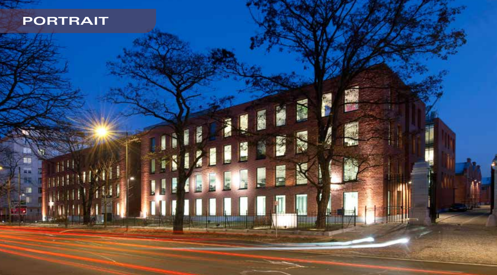
Projet ARSENAL - Bureaux - AG Real Estate - 2007 (BE) ©Marc Detiffe
